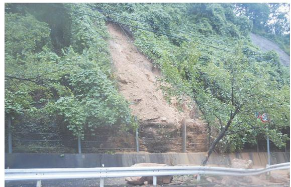
しかし、2日間続いた豪雨のため、頂上部の吹き付けコンクリートの内側で土砂崩れが発生してコンクリートを壊し、ネットを破って巨石や土砂が落下した模様です。現場周辺は同じコンクリート吹き付けの急斜面が続いています。
